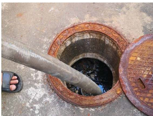
ภาพที่ 2.2-11 การสูบน้ำก่อนระบบบำบัดน้ำเสีย
